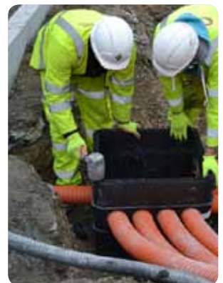
Aanleg systeem Ierland
